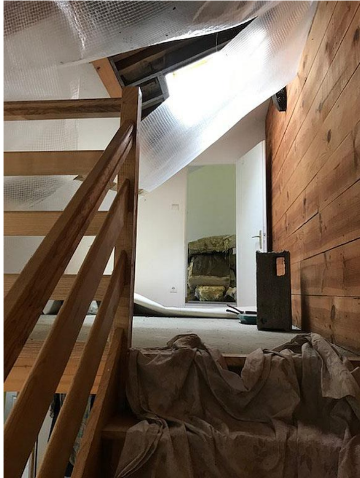
Sur la mezzanine, le placo et l'isolant ont également été enlevés
