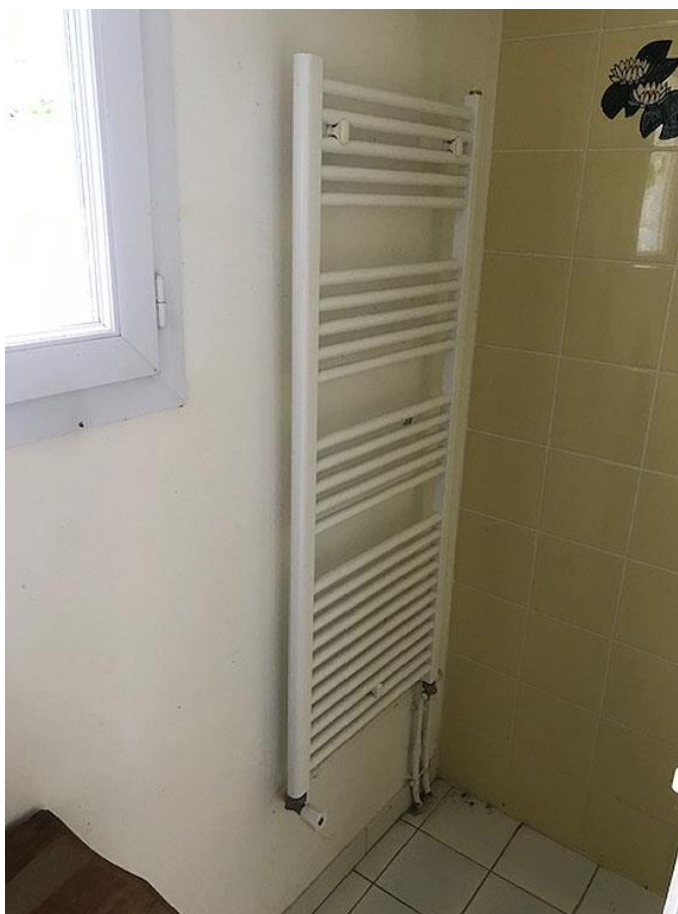
Un sèche serviette est présent La douche est recouvert de carrelage du sol au plafond
